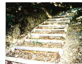
間伐材を利用した階段。里山林の育成管理で伐採された樹木をチップ化して舗装材として敷きならしています。
